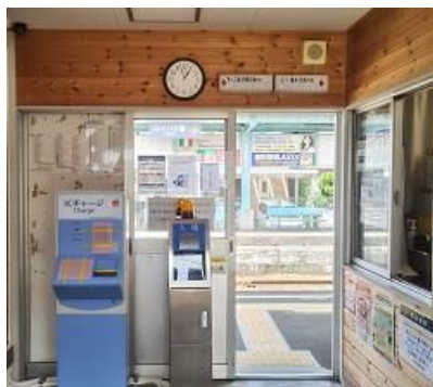
駅設置機器 (チャージ機・入場器)
