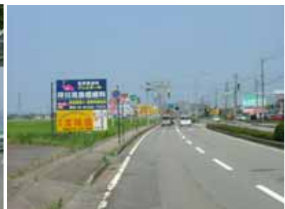
国道158号(和田中町付近)
