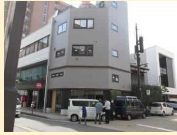
⑪浜町ビル
