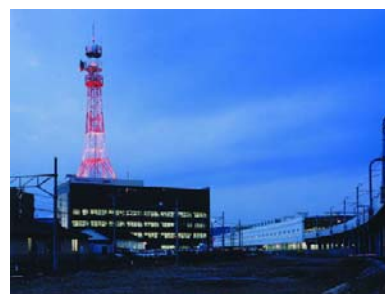
◆北陸電力福井支店社屋鉄塔
