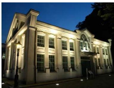
◆旧足羽揚水ポンプ場
