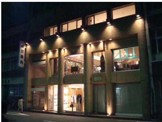
良好にライティングされた建築物の例
