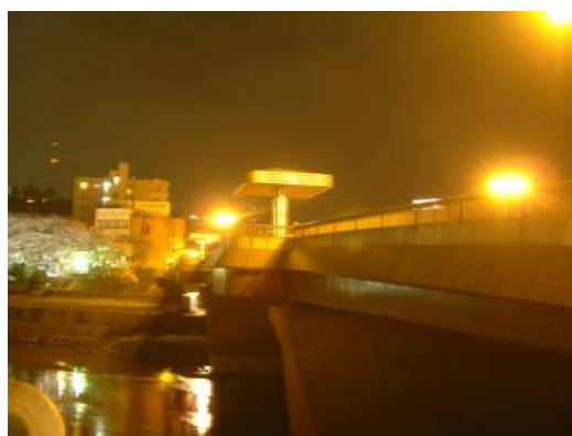
橋中のポケットスペース（九十九橋）
