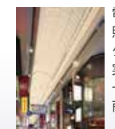
キャノピーに改修し間接照明と光柱を設置（田辺商店街）
