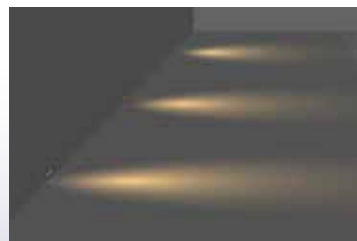
埋設照明による路面投光
