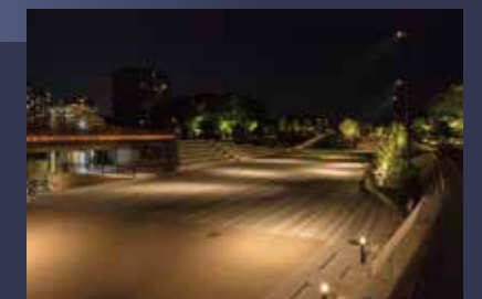
全域を調光制御することで、深夜のエネルギー消費を抑えている草津川跡地公園（草津市）
