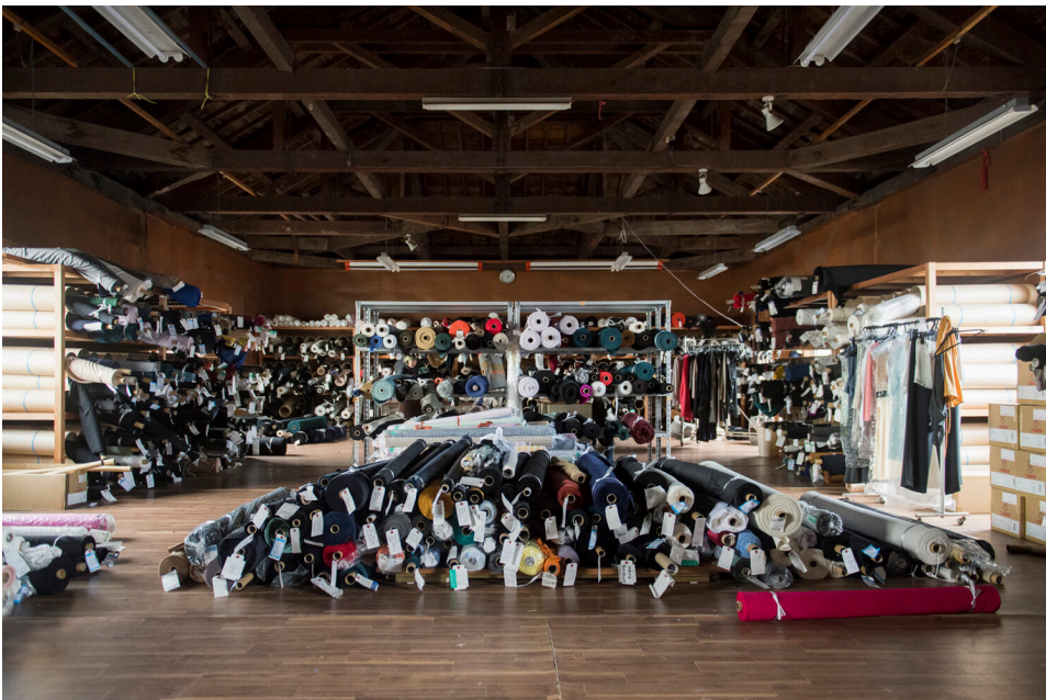
▲築80年の木造倉庫はもともと小学校として使われていたそう。屋根の構造も当時のまま
