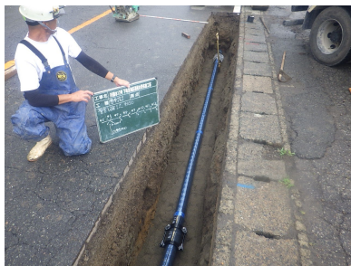
水道管布設状況
