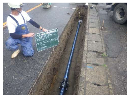
《送配水管布設工事》
