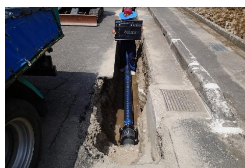
《配水管布設替工事》
