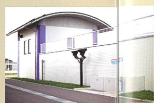
災害時給水施設②
