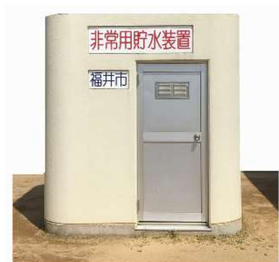
非常用貯水装置上屋
