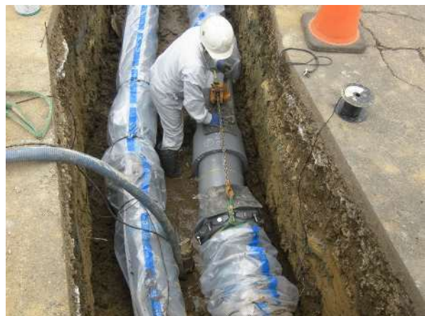
水道管の布設状況
