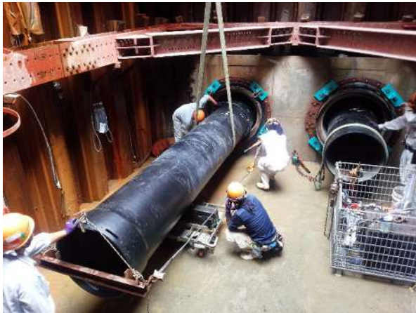
NS 形ダクトイル鋳鉄管布設状況（原目町）
