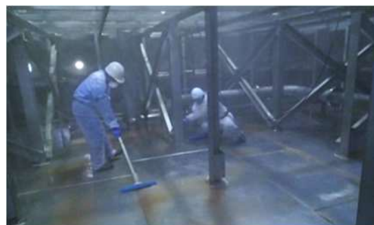
配水池の清掃作業状況
