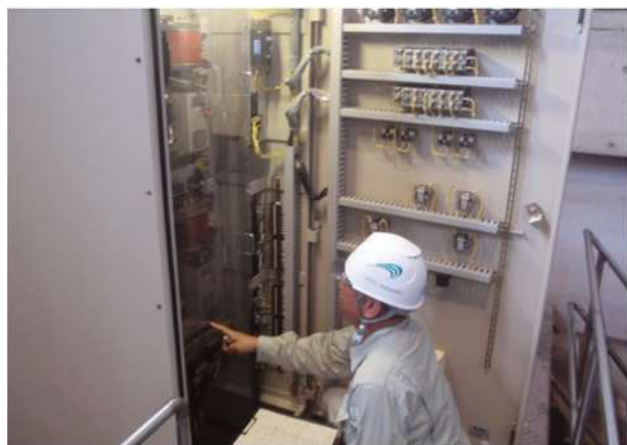
日常点検状況
