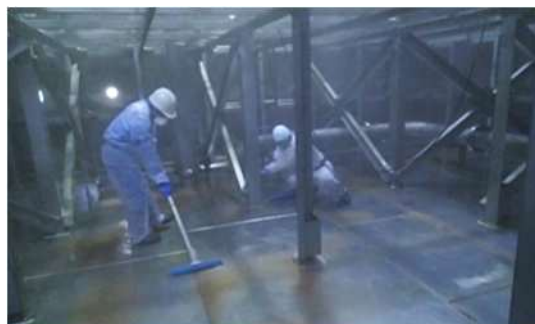
配水池の清掃作業状
