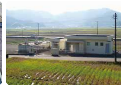
田治島浄水場
