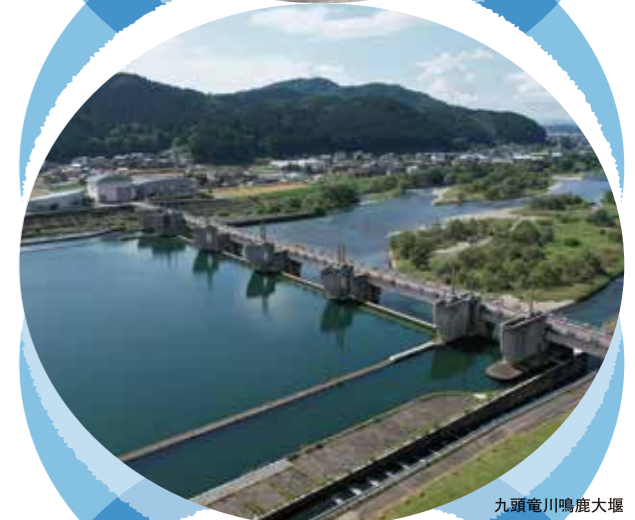
九頭竜川鳴鹿大堰
