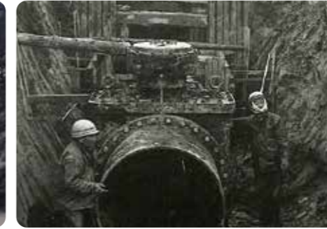
昭和30～40年の工事風景
