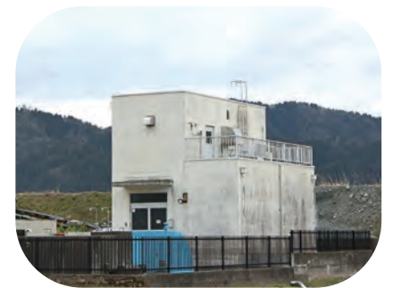
篠尾浄水場 S63(1988)建設 施設能力:800m 3 /日
