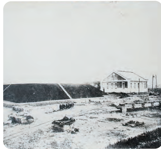
一本木浄水場工事状況
