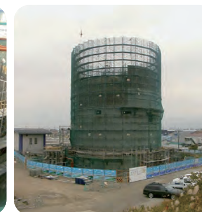
森田浄水場 配水塔 躯体施工中
