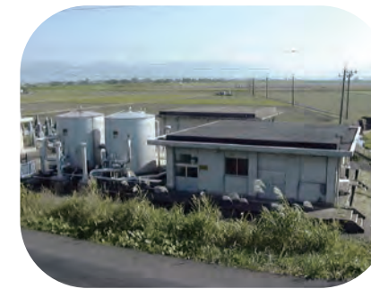
川西浄水場 S54(1979)建設 施設能力:1,780m 3 /日
