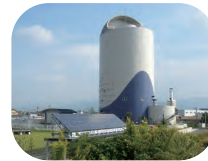
森田浄水場 H17(2005)建設 施設能力:14,700m 3 /日
