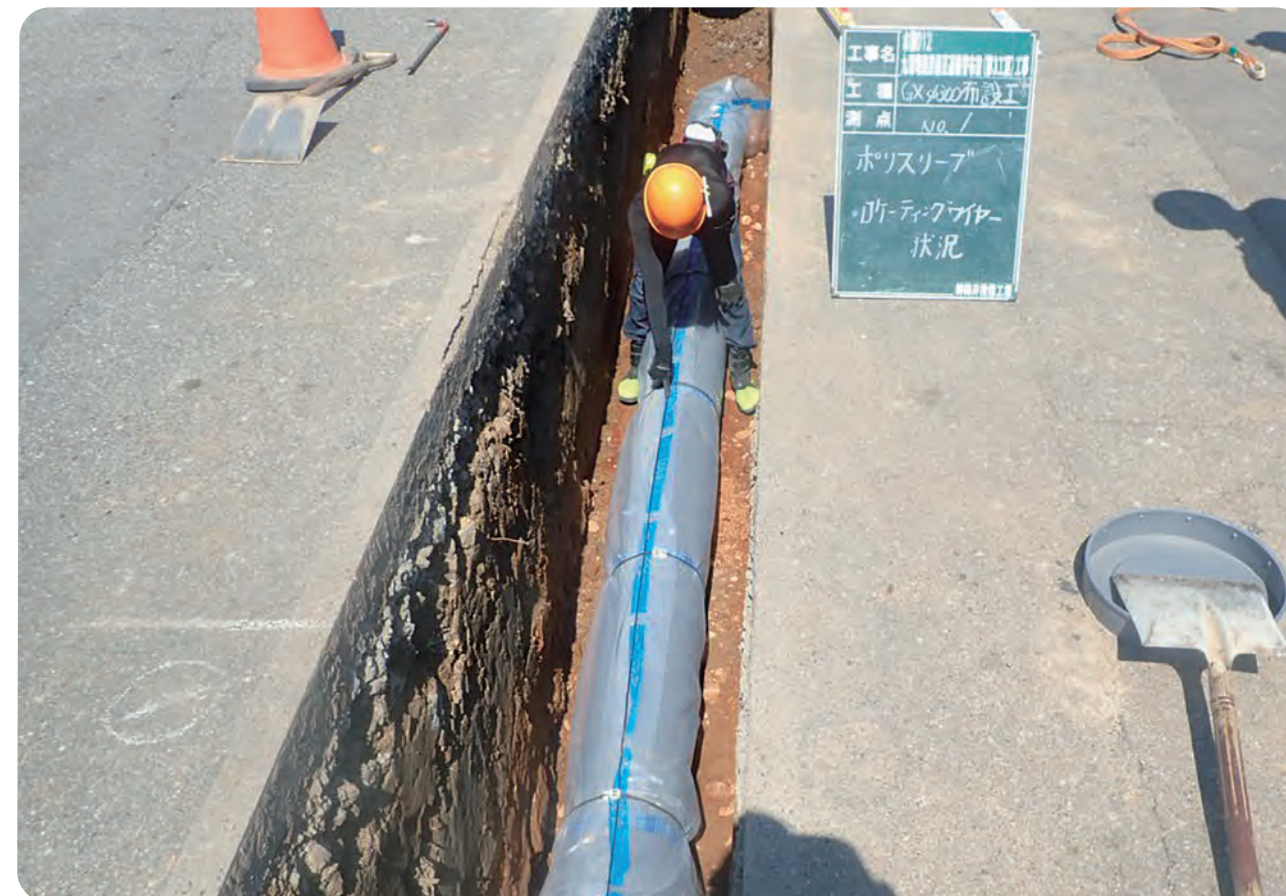
水道管の耐震化工事
