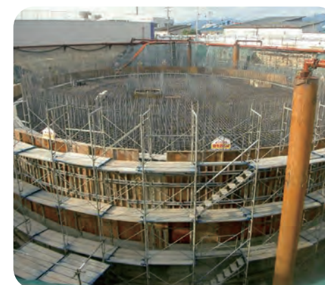
森田浄水場 配水塔耐圧版 施工中
