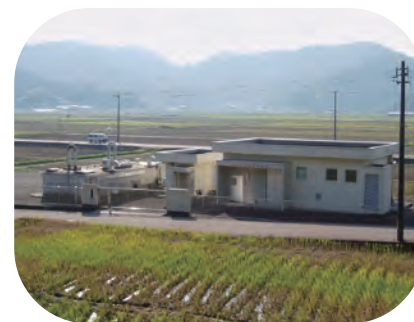
田治島浄水場 H5(1993)建設 施設能力:4,200m 3 /日
