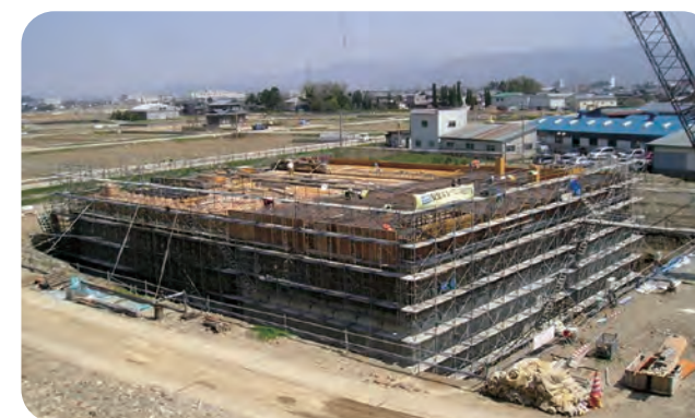
森田浄水場 浄水池 躯体施工中
