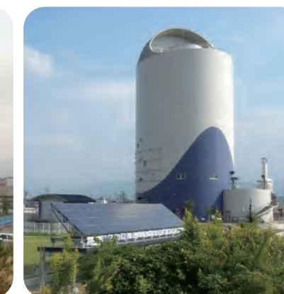
森田浄水場 配水塔 完成
