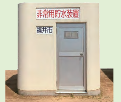
非常用貯水装置上屋
