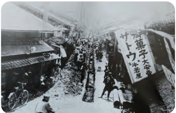
水道創設時の工事作業風景(大正13年)
