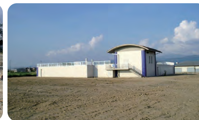
森田浄水場 浄水池 完成
