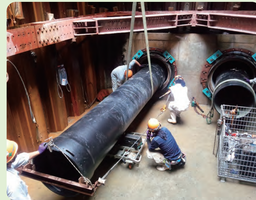
NS形ダクタイル鋳鉄管布設状況(原目町)
