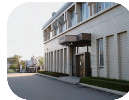
一本木浄水場 S46(1971)建設 施設能力:7,100m 3 /日
