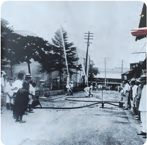
市役所付近消火栓使用試験
