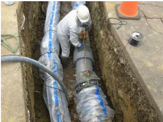
水道管の布設状況
