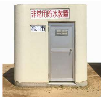
非常用貯水装置上屋
