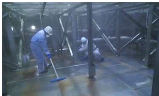
配水池の清掃作業状
