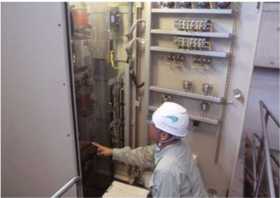
日常点検状況
