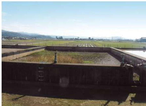
天日乾燥床（九頭竜浄水場）
