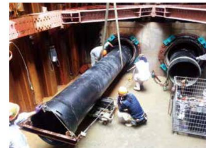
<ダクタイル铸铁管の布設状況>
