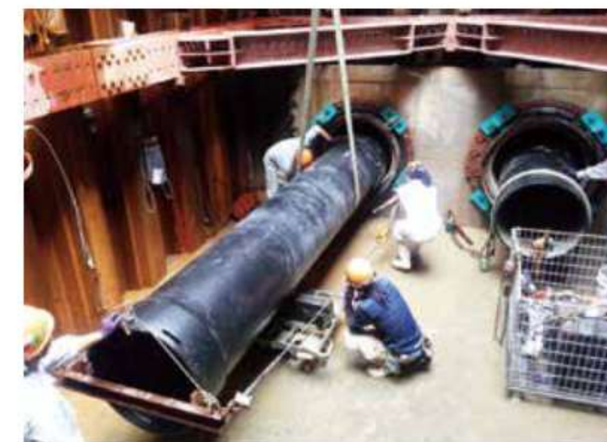
<ダクタイル铸铁管の布設状況>
