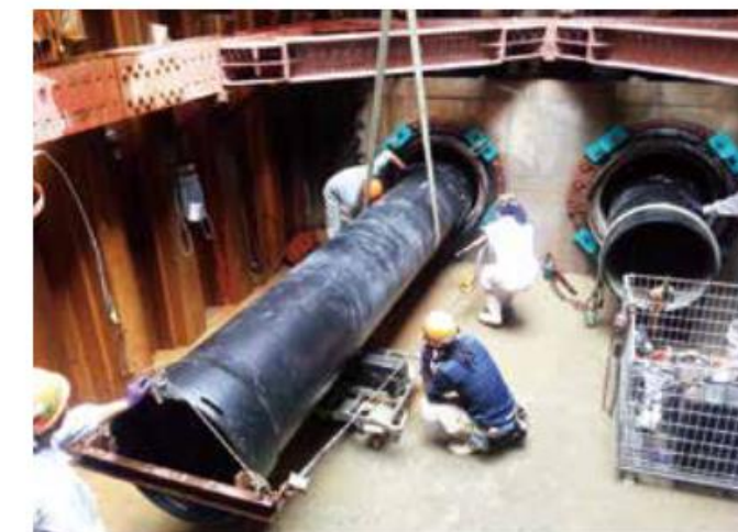
<ダクタイル铸铁管の布設状況>
