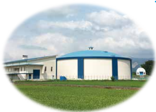
九頭竜第1配水池 平成28(2016)年度完成 配水池有効容量：15,000m 3
