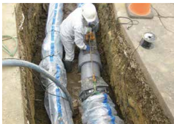
水道管の布設状況
