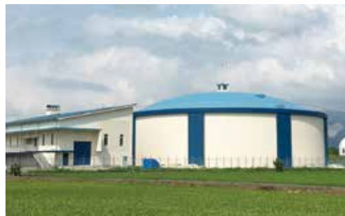
九頭竜第 1 配水池
