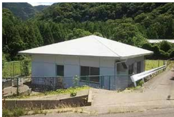
大味送水ポンプ場（北部簡易水道事業）
