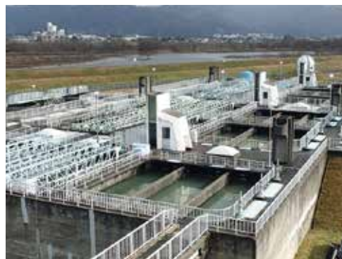
九頭竜浄水場の薬品沈殿池
