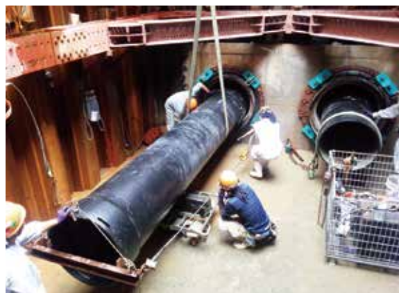
NS形ダクタイル鋳鉄管布設状況（原目町）
