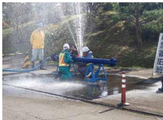
応急復旧訓練状況
