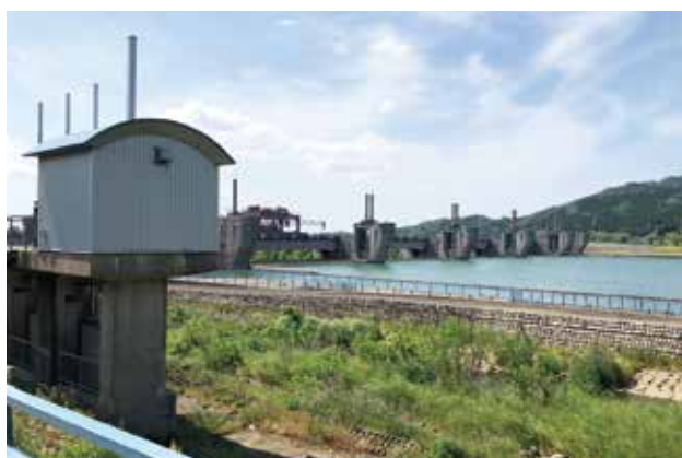
鳴鹿大堰取水口
