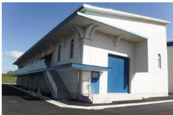
九頭竜送水ポンプ場
