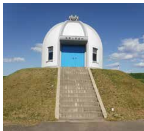
九頭電浅第1水源井
