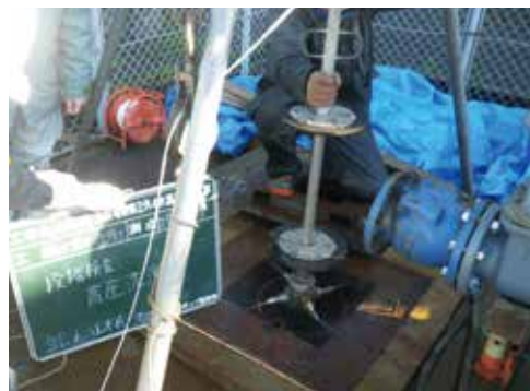
井戸改修状況
