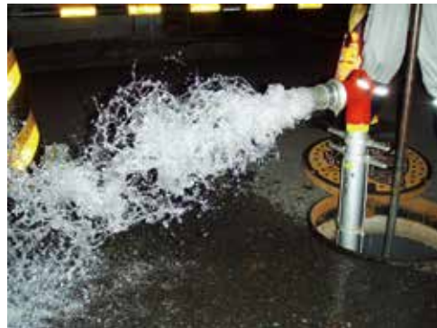
洗管作業状況
