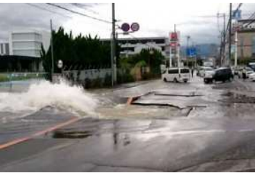
漏水による陥没
