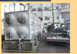
▲南越前町 受水塔への緊急給水の様子
