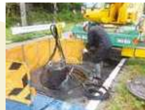
復旧作業の様子
