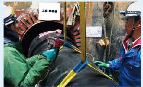
送水管を布設します。写真は口径 700 mm
