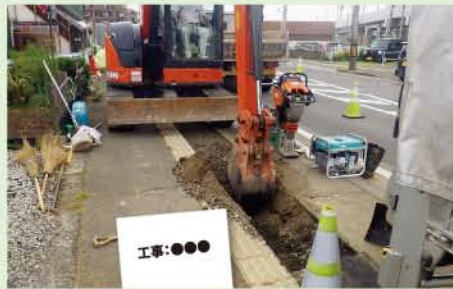
新しいガス管を布設するために機械で掘削します。
