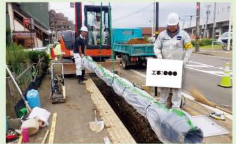
地震に強いガス管を布設します。
