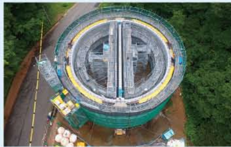
新末配水池築造工事を上空から撮影
