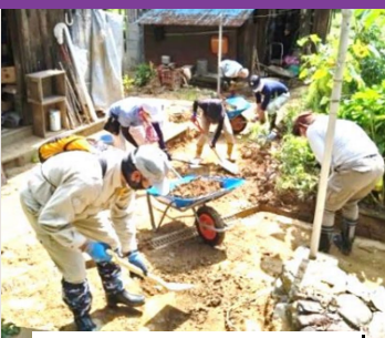
被災家屋の泥撤去などの復旧作業支援 （南越前町）
