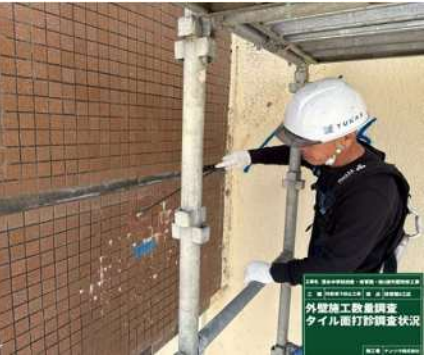
【体育館タイル面打診状況】
