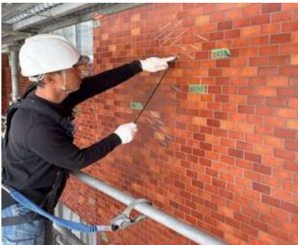
【校舎タイル面打診状況】
