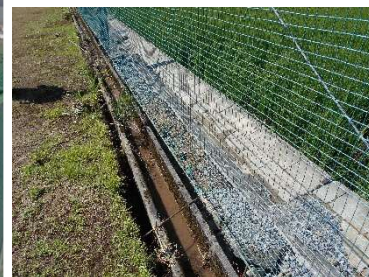
擁壁倒伏（隣地水田を侵食）
