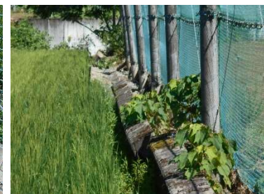
擁壁倒伏（隣地水田を侵食）
