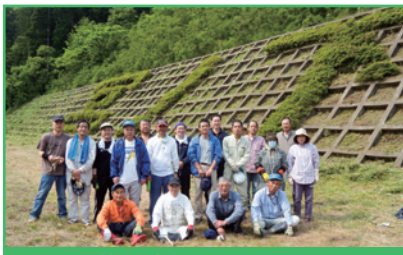
天菅生橋法面の草刈り活動
