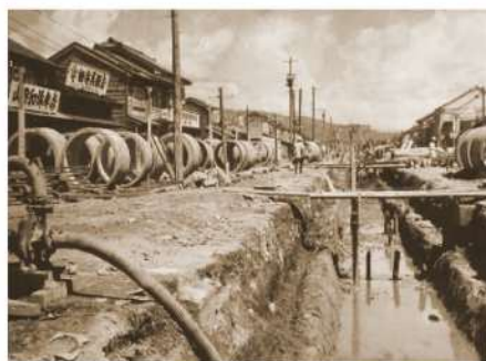
下水道整備工事（都市基盤整備）
