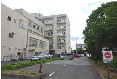
西側の隣接建築：南側からみる
