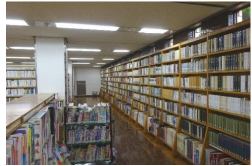
壁面書架：公園側壁面は構造壁ではないので開 放可能、現在は天井近くまで壁面書架で埋め尽 くされている
