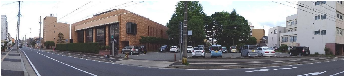
北・前面道路からみた全景：奥に木々の生い茂る公園があるが、あまり利用されていない。図書館西側は駐車場
