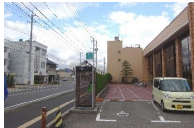
玄関前広場：閲覧室内部はみえない
