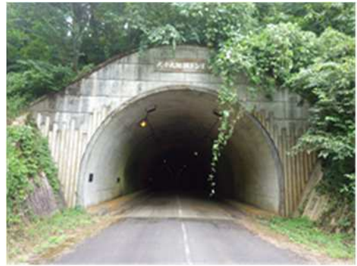
長寿命化対策を講じたトンネル
