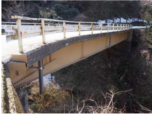
長寿命化対策を講じた橋梁
