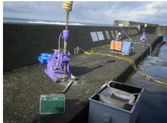
防波堤の改修
