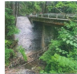
(老朽化対策を実施した橋梁)
