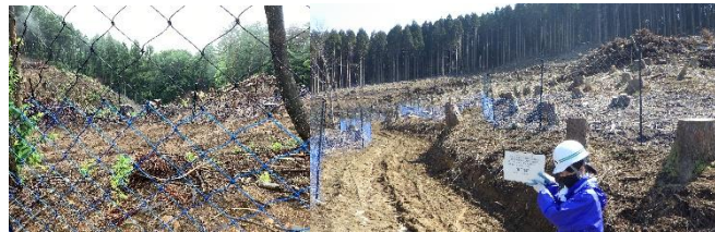
(防護柵の設置)
