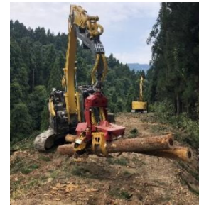
(高性能林業機械での作業)
