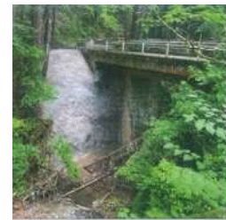
(老朽化対策を実施した橋梁)
