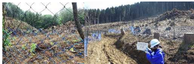
(防護柵の設置)
