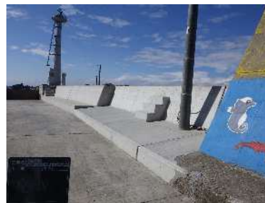
老朽化した漁港施設の改修
