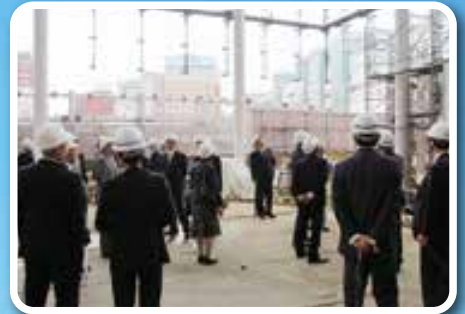
平成27年11月2日、建設中の福井駅西口再開発ビル「ハピリン」内を議員が視察し、完成後の活用とにぎわい創出について活発な意見を交わしました。
