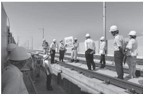
北陸新幹線高柳高架橋
