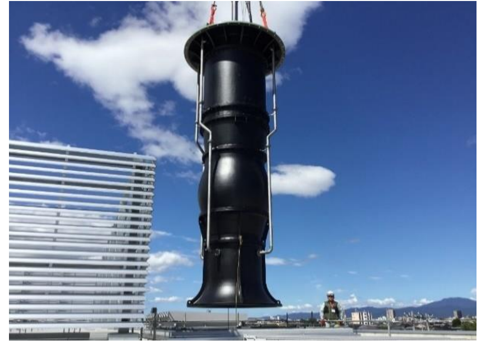
（雨水ポンプを加茂河原ポンプ場に搬入する様子）
