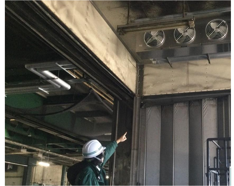
（空調設備工事管理業務の様子）
