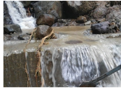
土石による取水口閉塞状況
