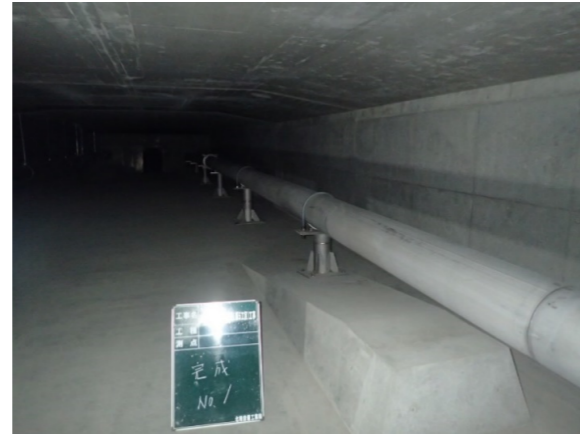
【橋桁内SUS管布設状況】
