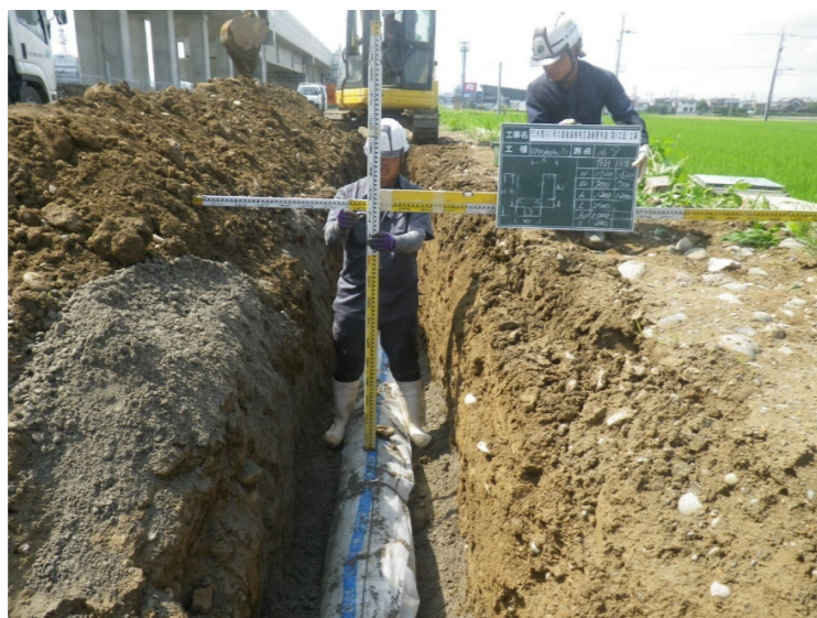
【道路工事同時施工状況】
