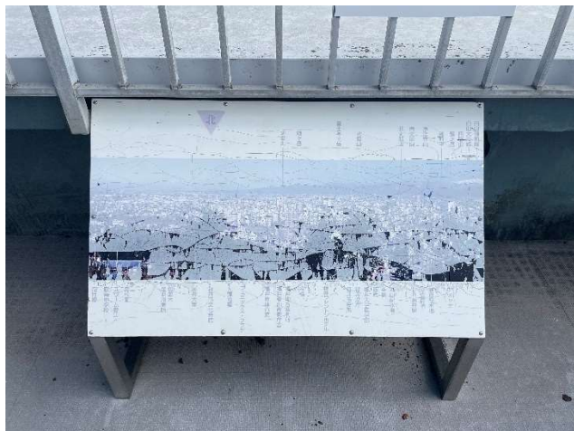
<屋上にあるパノラマサインの表示劣化（一部）>
