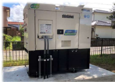
<空調設備(発電機)>
