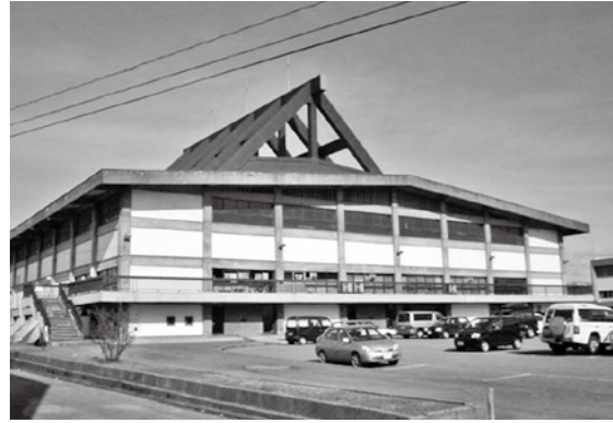
▲市体育館を安心して快適に利用できるように、耐震補強・大規模リニューアル工事を行っています。
