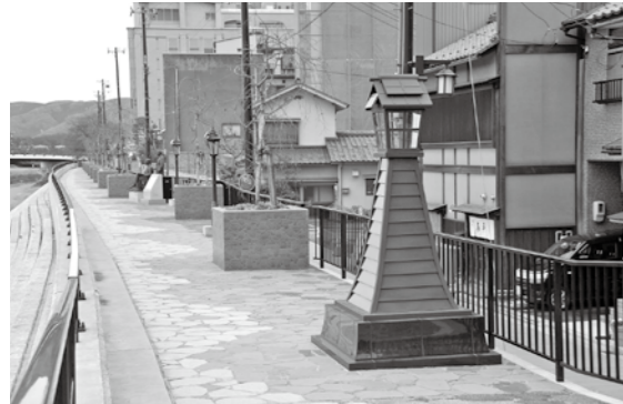
▲歴史に親しみ、憩えるまちづくりを目指して、景観や歴史的資産に恵まれた浜町通り界隈（中央3丁目）の整備を進めています。平成21年度には「さくらの小径」が完成しました。
