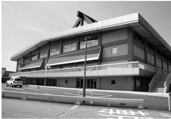
▲安心して快適に利用できるよう、耐震補強などを行ってきた市体育館のリニューアル工事が、平成22年度に完了しました。
