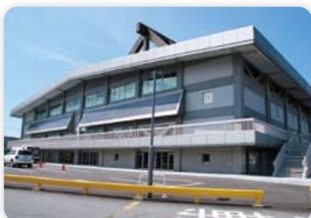
耐震補強や冷暖房などの改修を行った市体育館
