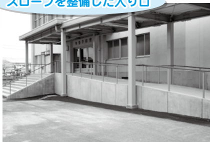
スロープを整備した入り口
