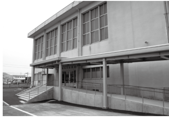
▲旧至民中体育館のバリアフリー改修工事を行い、障がい者や県外学生が優先的に使用できる「ちもり体育館」を整備しました。
