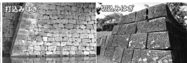
**初**代福井藩主・結城秀康が1601年から約6年かけて築城。4万個の笏谷石のみでつくられた本丸の石垣と堀が今も良好に残っています。本丸の石垣は四角く割った石を積む「打込みはぎ」㊦で、天守台の石垣は、割石を精密に削り、隙間なく積む「切込みはぎ」㊧という積み方で積まれています。当時の石積み技術を間近で見ることができます。
