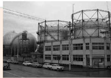
旧ガス工場(昭和47年)
