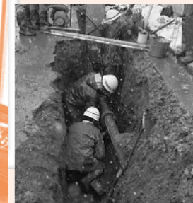
ガス導管の交換作業
