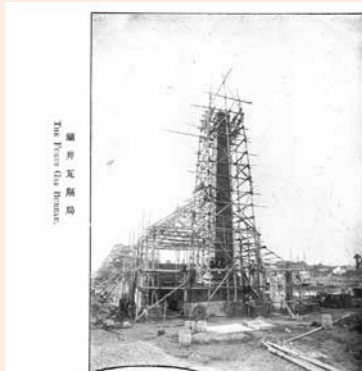
建設中の瓦斯局（「瓦斯界」明治45年2月号、GAS MUSEUMが資料館）
