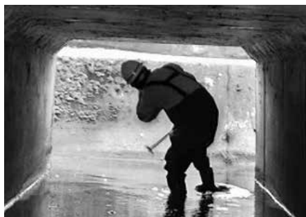
傷んでいるところがないか目で確認したり、ハンマーで叩いて音を確認（市道 中角町付近）
