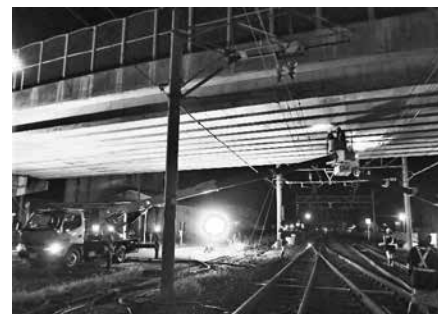
鉄道をまたぐ橋梁の夜間点検（花堂 はなどう 跨線橋 くせんきょう 花堂北1丁目付近）
